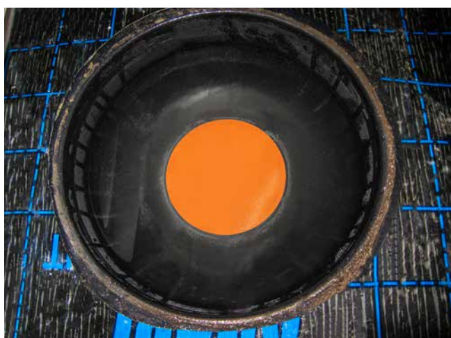
intégration facile du pare-vapeur sur la flasque pour collage
