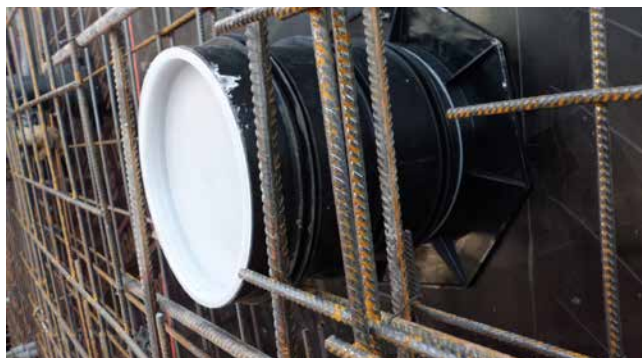
UFR dans le coffrage
