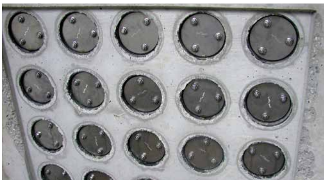
FZR100/240 – étanchement, tracé des tubes
