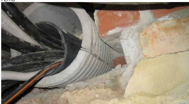
FZRG150/350 – assainissement dans la maçonnerie
