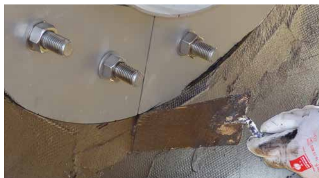
FLFE 300/X version acier inoxydable liée au revêtement bitumineux épais plastique modifié à l'aide d'une garniture d'étanchéité non tissée, voir Page 79 et suivantes
