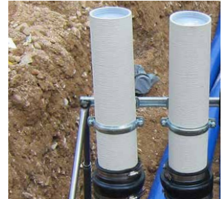
Disposition en rangées de 2x KES MA150 ZVR150/500 sur le dispositif d'installation KES FUBO-FIX AV
