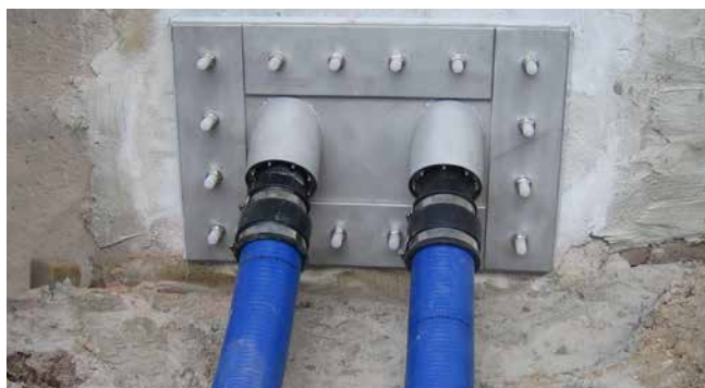
flasque fixe/amovible avec raccordement de fourreau incliné avant l'étanchéification superficielle
